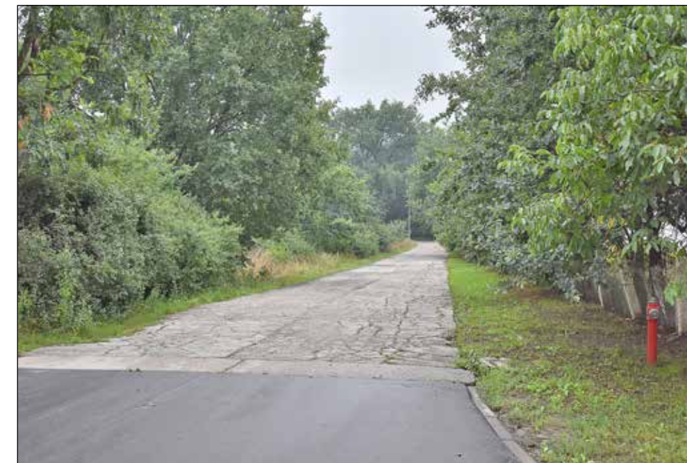
Ul. Dębowa, wykonano odcinek infrastruktury wodociągowej o długości 390 m z rur PE \phi 160 od skrzyżowania z ul. Paderewskiego do „mostku”.
