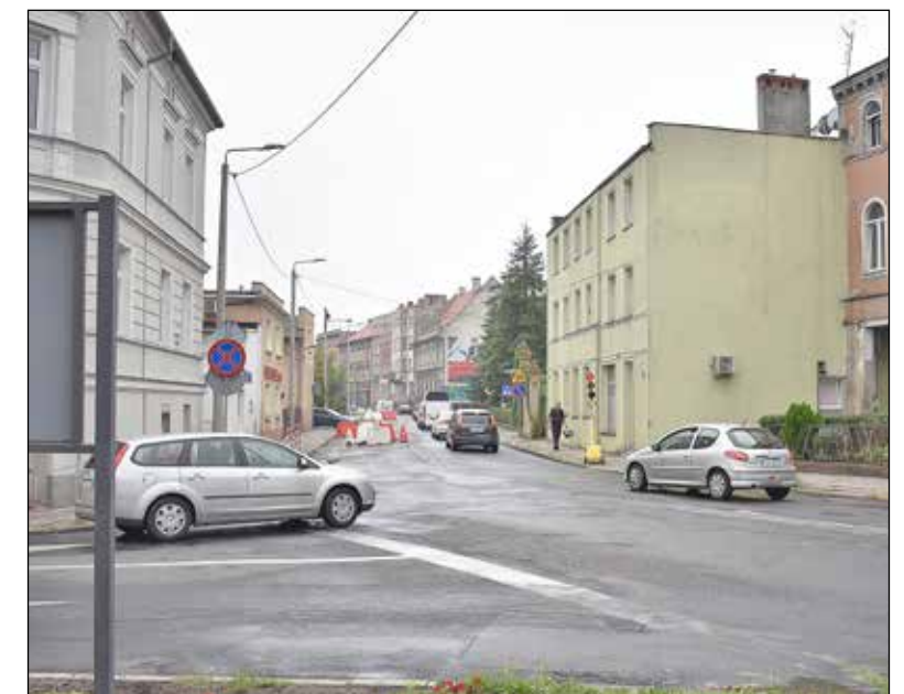
Ul. Wrocławska, wymieniono kolejny odcinek infrastruktury wodociągowej o długości 320 m z rur PE \phi 160.
