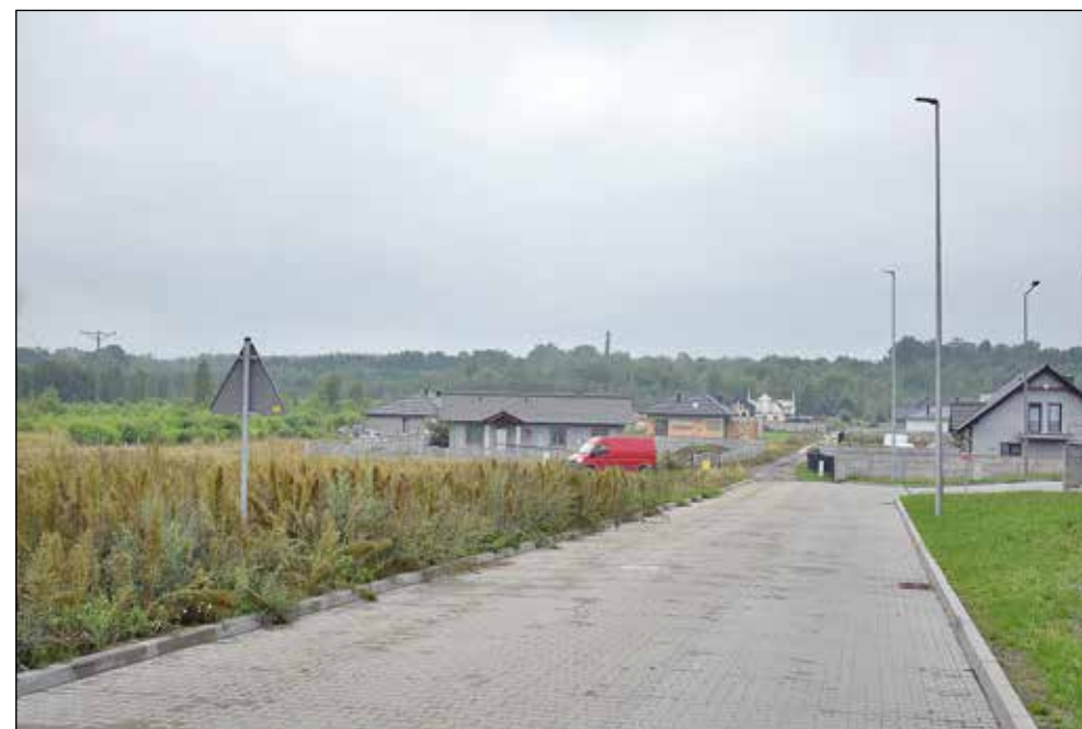
Ul. Szyborska, wykonano 580 m sieci wodociągowej z rur PE \phi 125. Dzięki temu mieszkańcy powstającego osiedla (23 nieruchomości), uzyskali możliwość podłączenia się do sieci.
