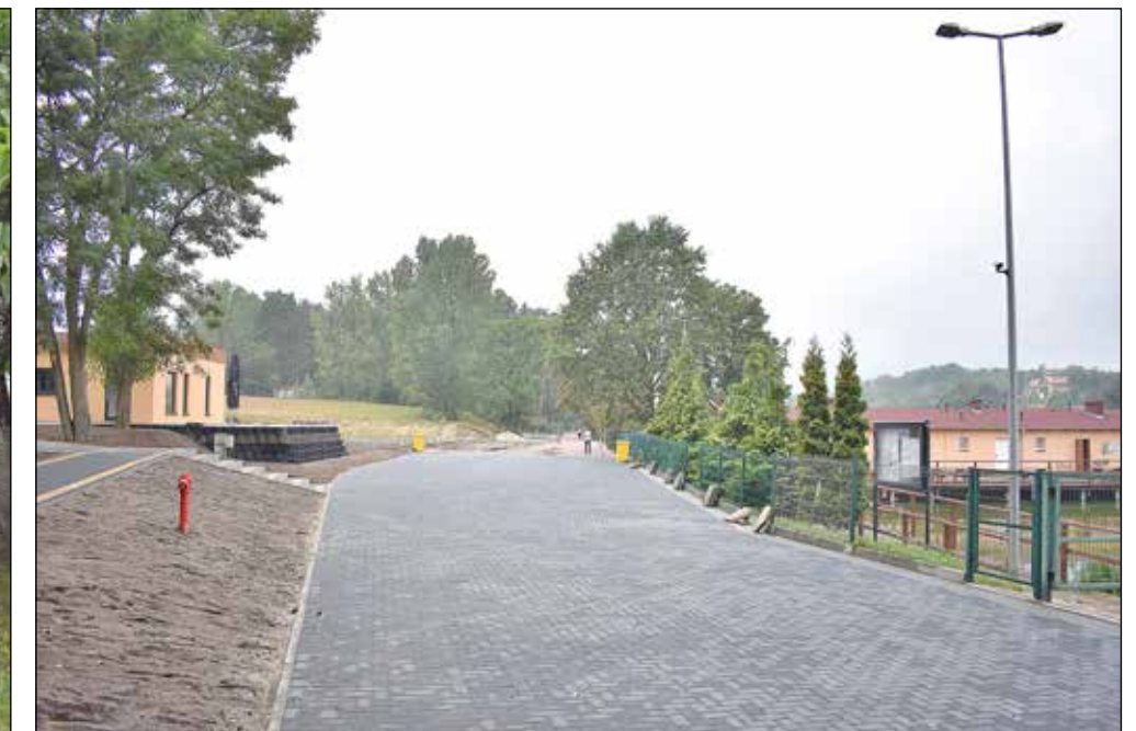
Zalew Karas, wykonano odcinek infrastruktury wodociągowej o długości 350 m z rur PE \phi 160 od ul. Robotniczej do przystani. Jednym z celów tej inwestycji było zabezpieczenie ppoż. Obiektu.
