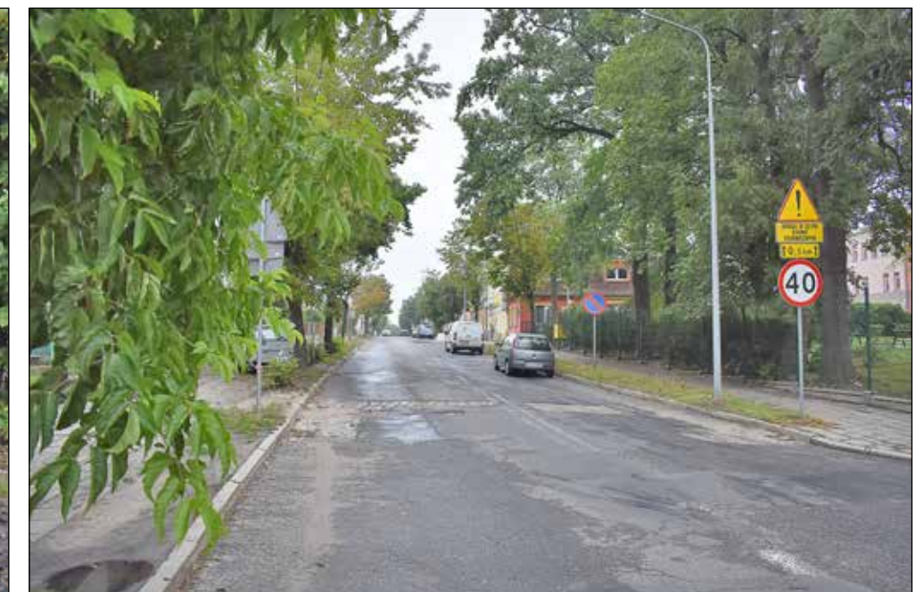
Ul. Poznańska, inwestycja o długości ponad 2 km z rur PE \phi 160 ma połączyć wodociąg od skrzyżowania: ul. Gdańska-Krakowskie Przedmieście, poprzez ul. Błotną - ze strefą ekonomiczną w Górzynie.
