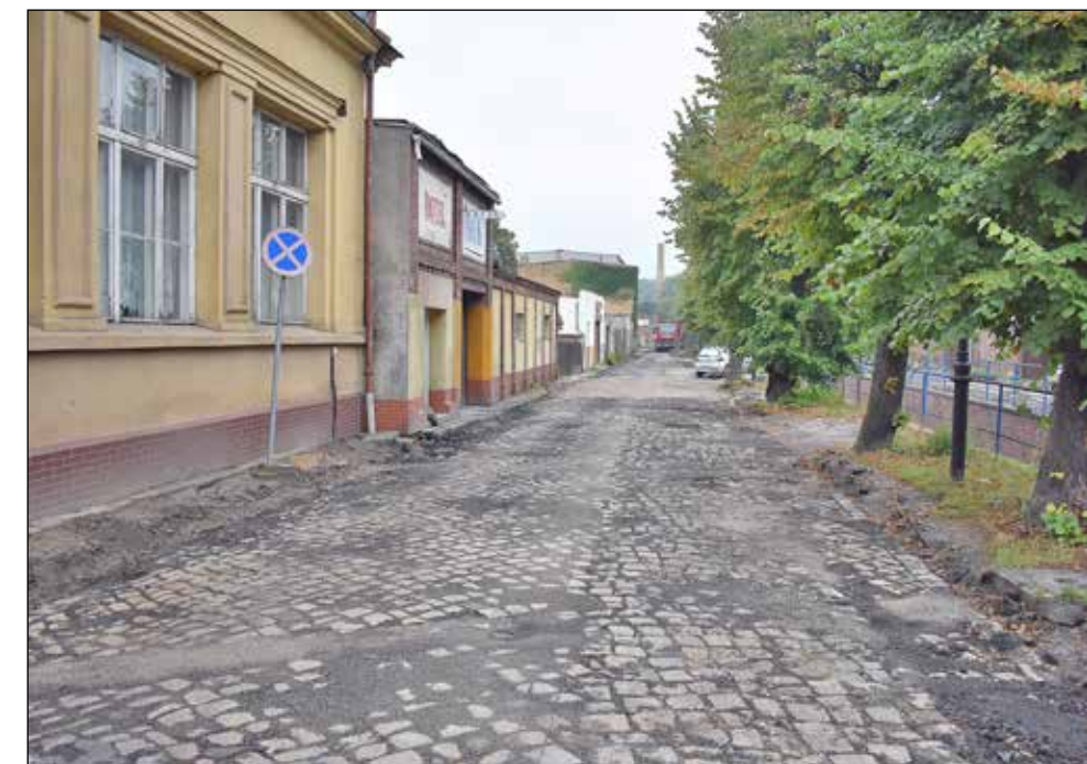
Ul. E. Plater, prace trwają; w sumie wymieniony będzie odcinek infrastruktury wodociągowej o długości 400 m z rur PE \phi 160 od ul. Bohaterów do ul. Reja.
