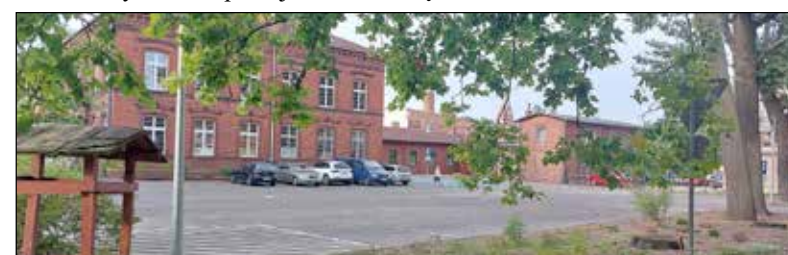
W wyniku realizacji I etapu inwestycji, zmodernizowano lewe skrzydło budynku oraz łącznik. Wykonano również dwa parkingi - jeden dla pracowników zlokalizowanych w obiekcie instytucji, drugi dla interesantów
