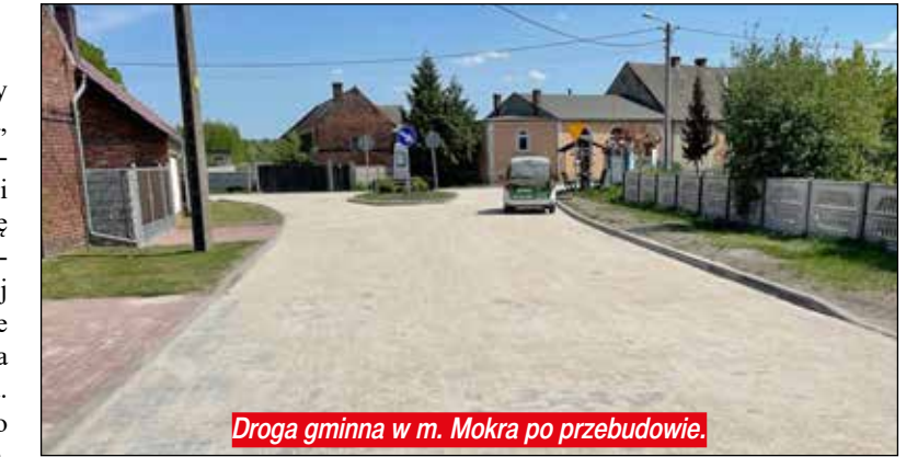
Droga gminna w m. Mokra po przebudowie.
