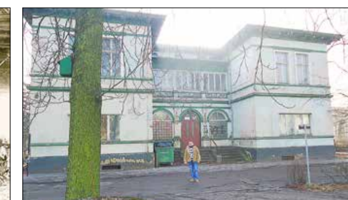
Willa Georga Beuchelta znajduje się w Zielonej Górze na terenie zakładu „Zastal”, obok „ALMEDEM - u” na ulicy Towarowej.
