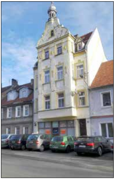
Budynek dawnej restauracji i kawiarni "Przyszłość" (fot. autor)
