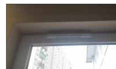
Rys.1. Nawiewnik higrosterowalny montowany na ramie okiennej. Źródło: Opracowanie własne
