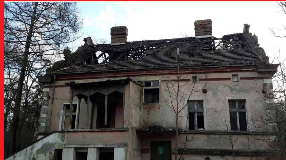
Na szczęście w porę udało się ewakuować mieszkańców tego domu
