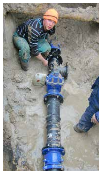
Przy okazji remontu ul. Bohaterów LWiK modernizuje sieć wodociągową
