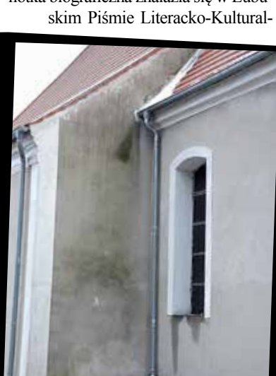
Wejście do krypty zamurowanej w latach 80-tych XX wieku
