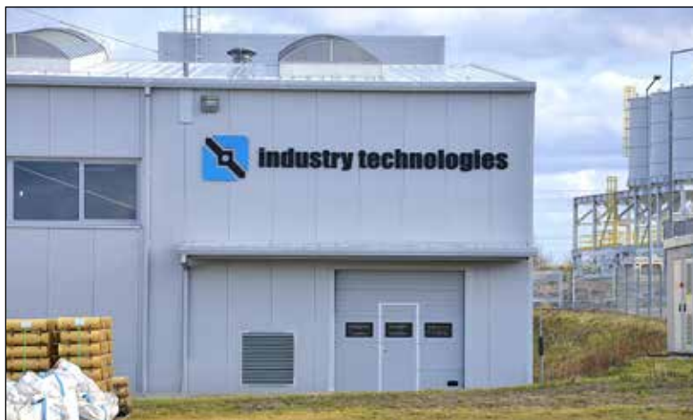
Indygo Technologies w środku jest gotowe i czeka na uruchomienie produkcji ceramicznych elementów izolacyjnych
