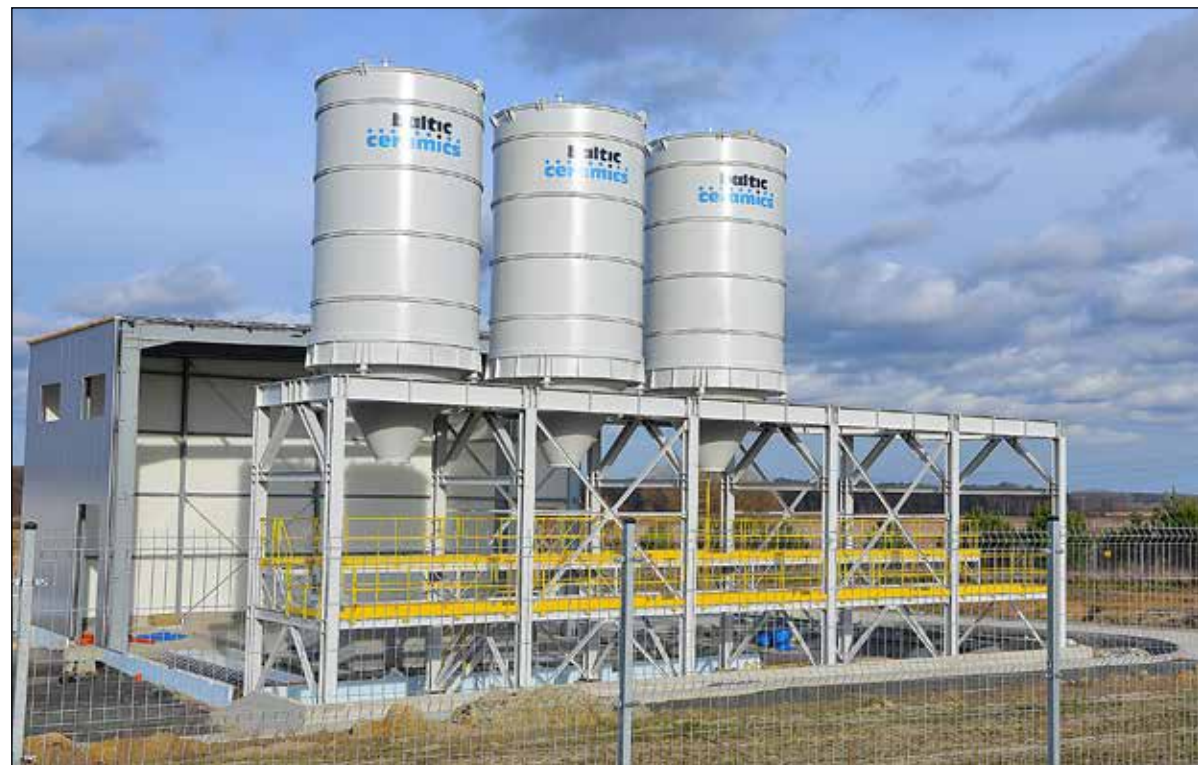
Trwa budowa zakładu BalticCeramics, który będzie produkował proppanty ceramiczne. Na fotografii silosy na surowiec
