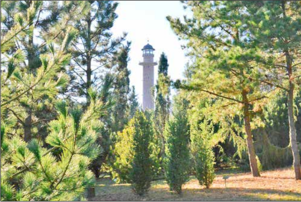
Murowana wieża przeciwpożarowo-widokowa ma wysokość 41m i przypomina latarnię morską
